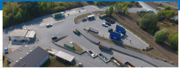
Abfallentsorgungsanlage Im Heiligenholze
